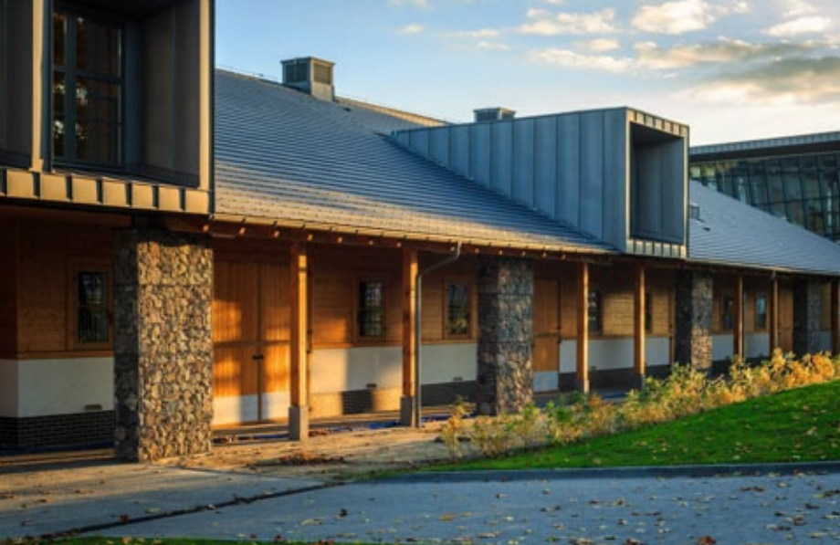
▲ Stajnie po rewitalizacji
