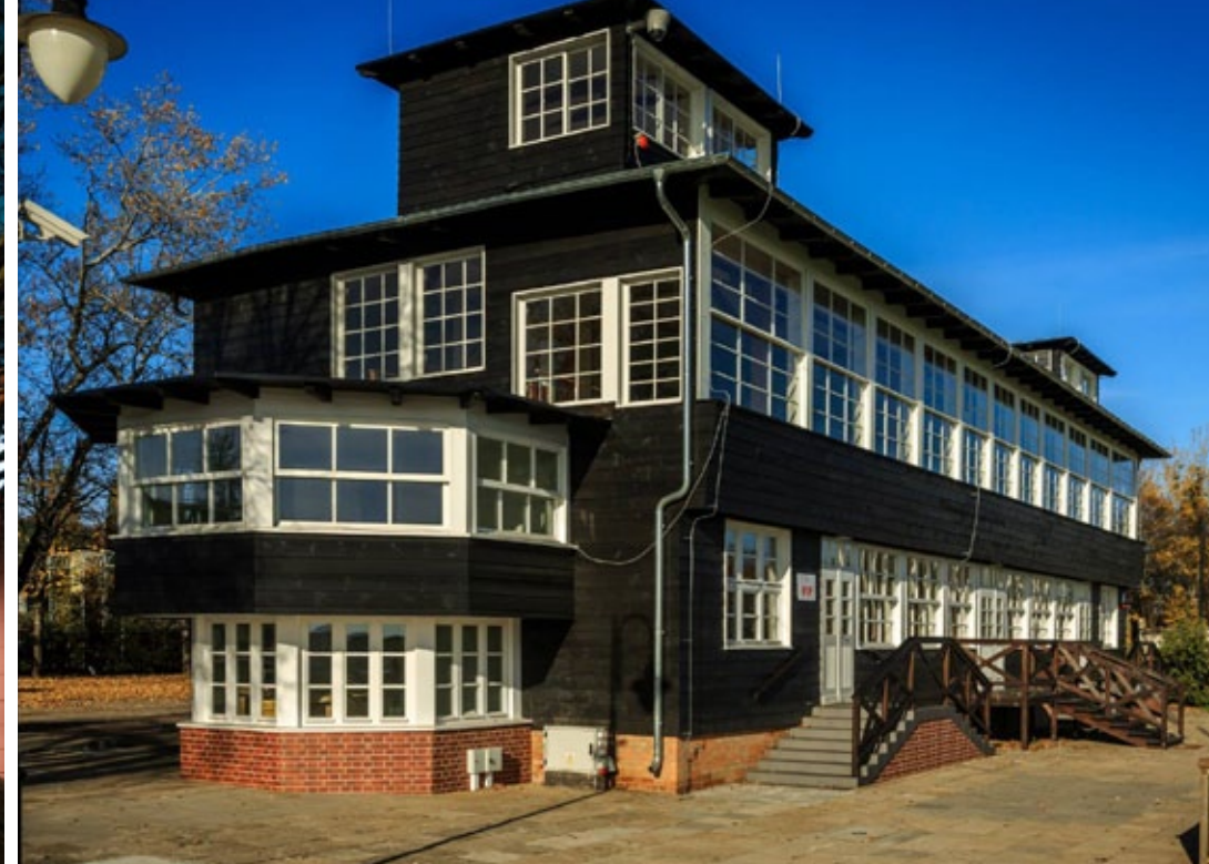
▲ Zabytkowa trybuna po rewitalizacji
