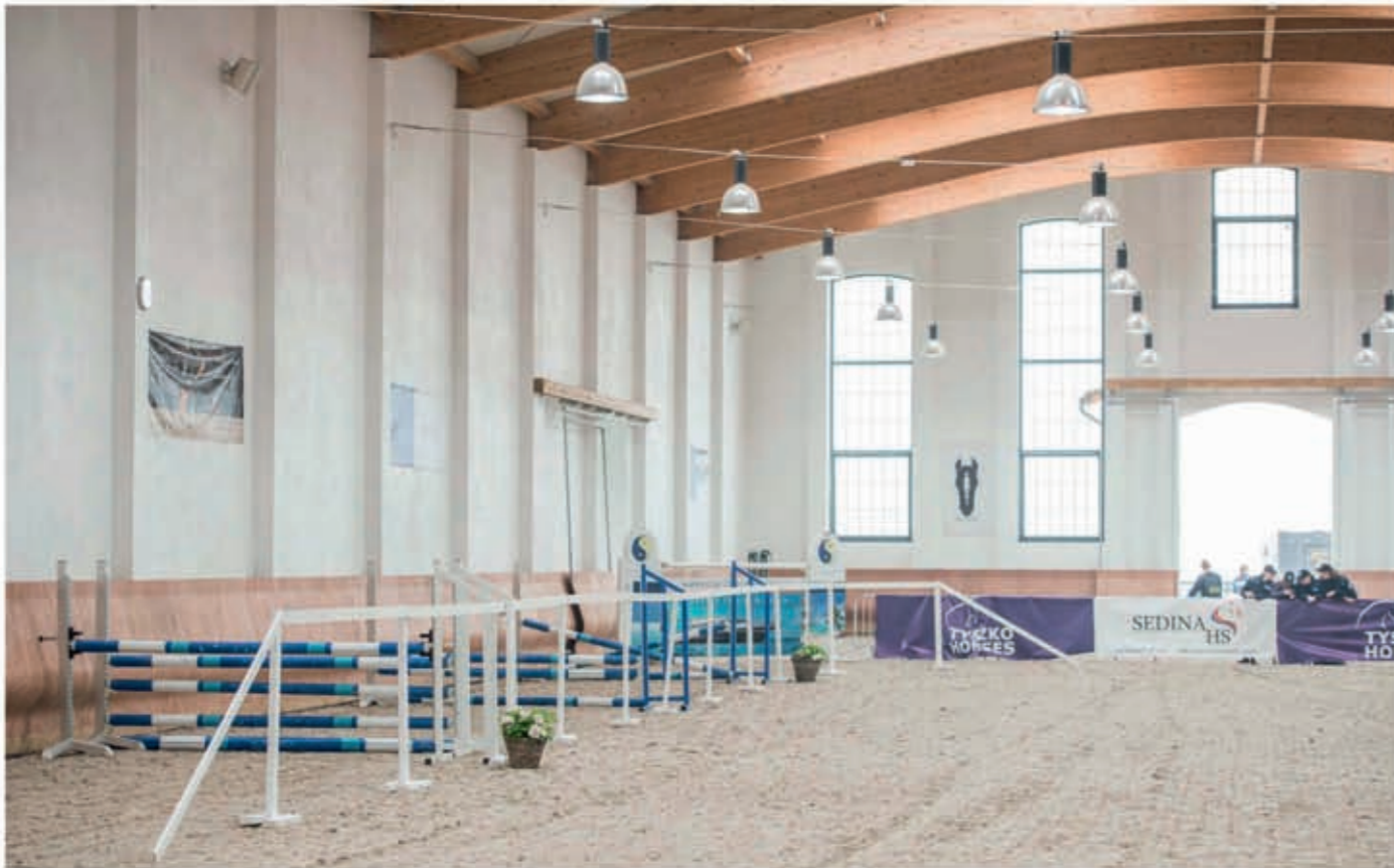
Zadaszona hala w Warniku poza wykonaniem i doбором materiałów, odznacza się nieprzeciętną estetyką zapewnioną dzięki technologii drewna klejonego, wykorzystanego przy konstrukcji dachowej. Aby poprawić komfort jazdy obiekt został wyposażony w specjalny wentylator, który zapewnia cyrkulację powietrza i eliminuje skraplanie się wilgoci. Fot. Oliwia Chmielewska
